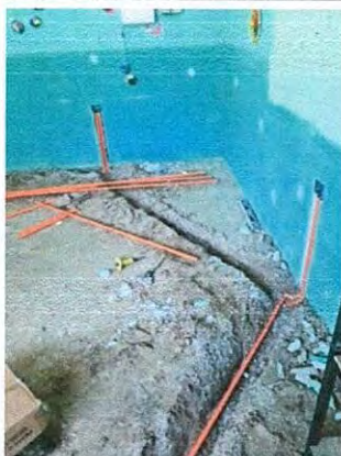
Foto 9: Cambio de la instalación eléctrica
