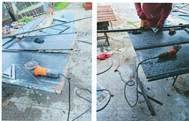
Foto 7: Corte, reparación y pintura de puertas
