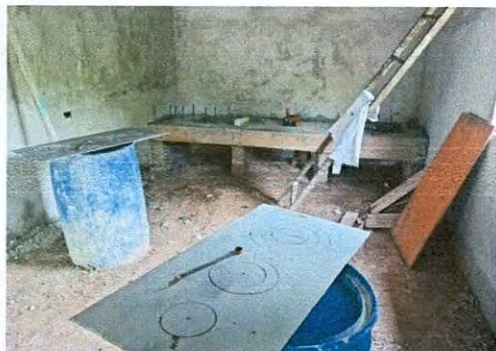
Foto 5: Repello en área de cocina
