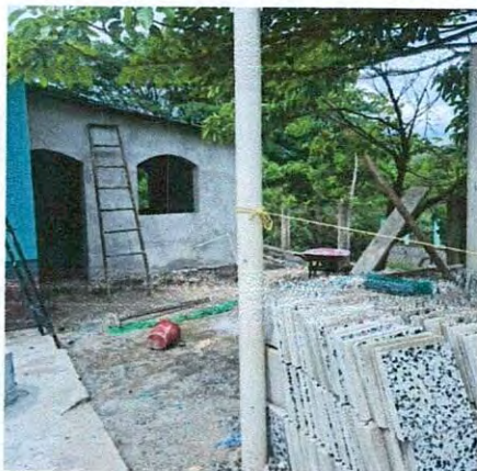
Foto 3: Proceso de remozamiento del área de cocina
